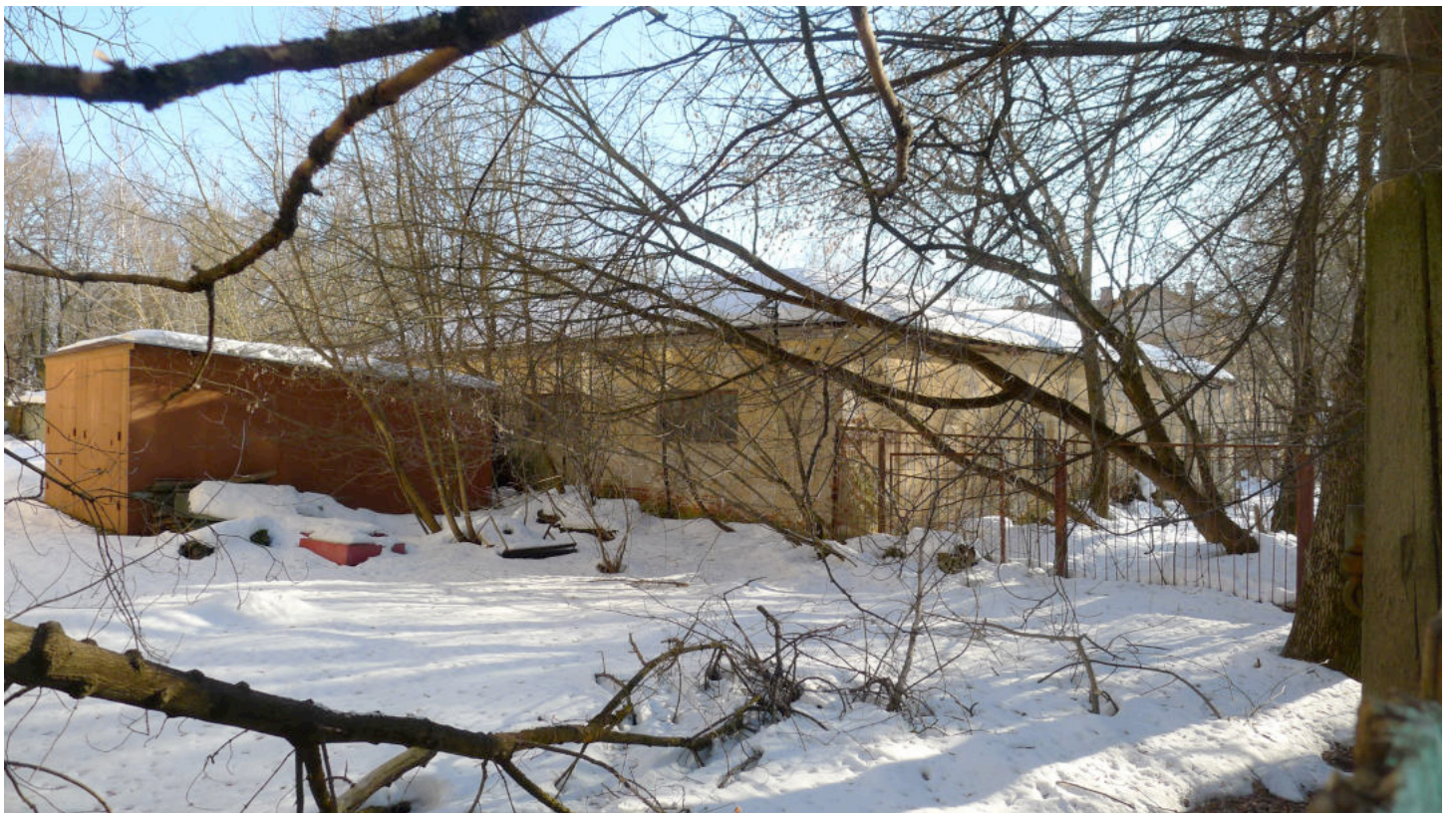
Фото 6. Вид с северо-запада.
