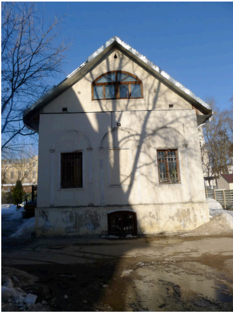
Фото 15. Кухонный флигель. Южный фасад.
