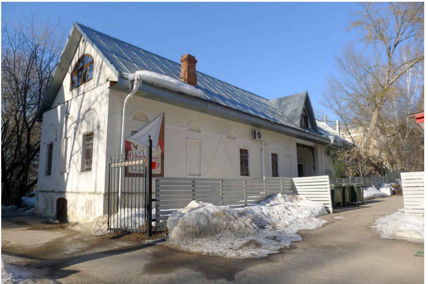
Фото 14. Кухонный флигель: объемы кухни и людской (дальше и правее). Вид с юго-востока.
