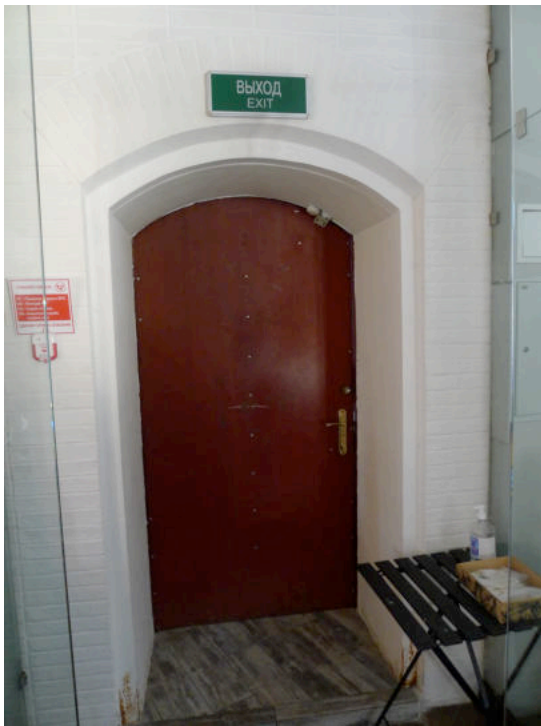
Фото 19. Проем входа в объем кухни. Вид в помещении.
