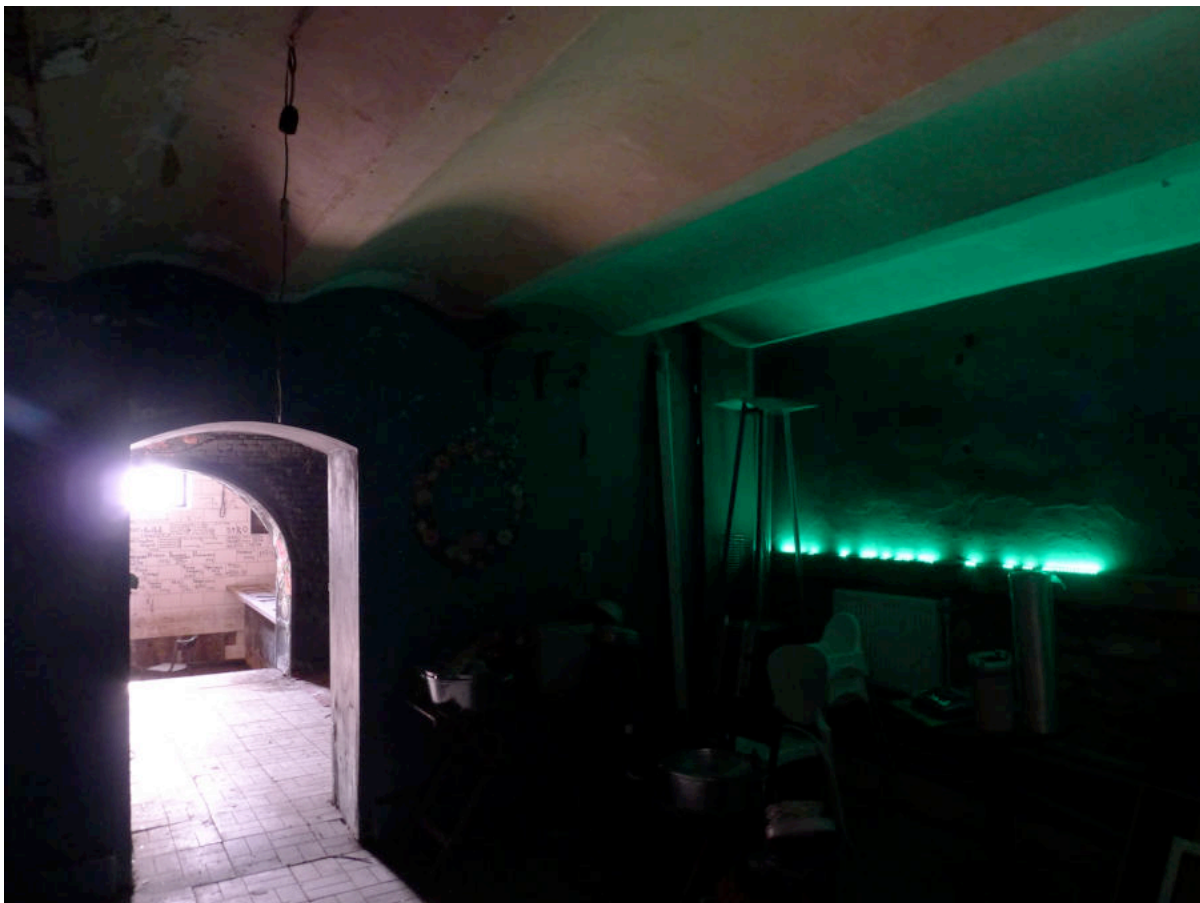
Фото 24. Своды Монье в северной части подвала кухни.
