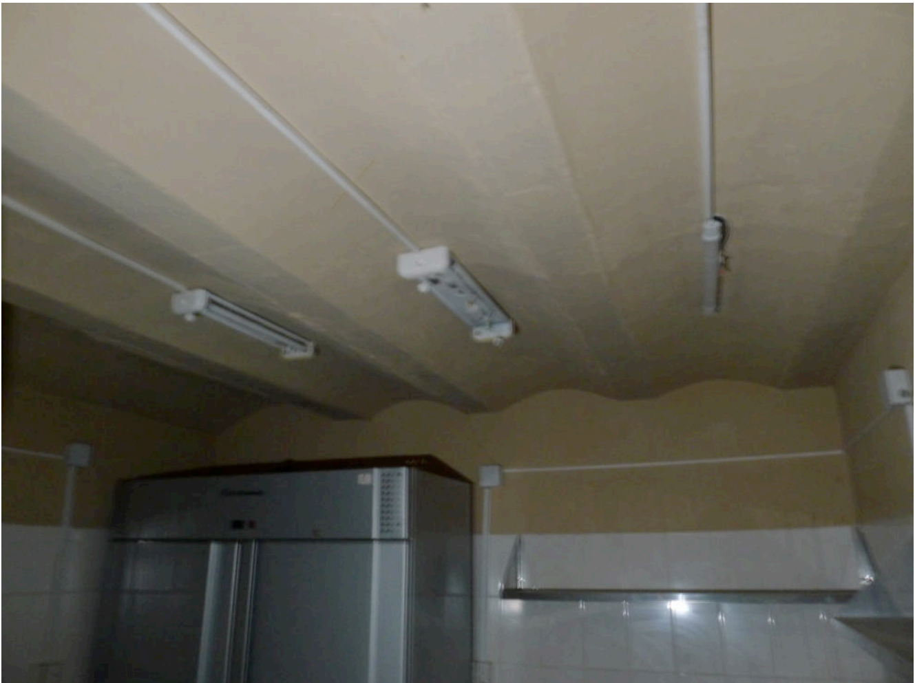
Фото 26. Своды Монье в подвале людской.
