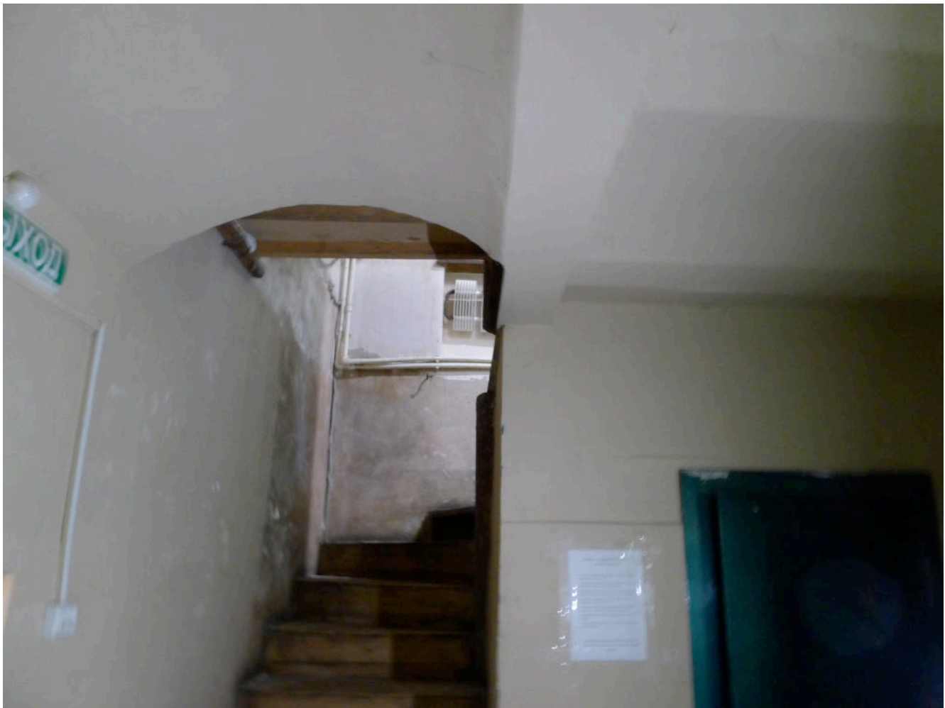
Фото 27. Лестница, ведущая из подвала в объеме людской.
