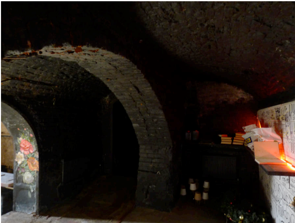
Фото 23. Коробовые своды на подпружных арках в средней части подвала кухни.
