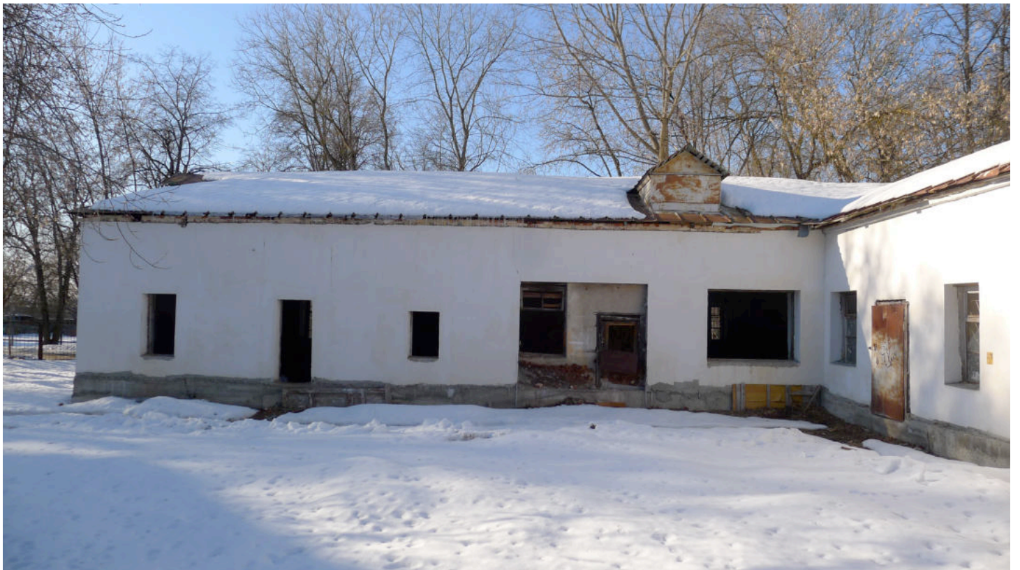
Фото 9. Западное крыло. Вид с востока.
