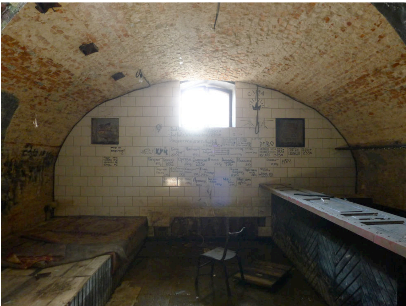
Фото 22. Коробовый свод в южной части подвала кухонного объема.
