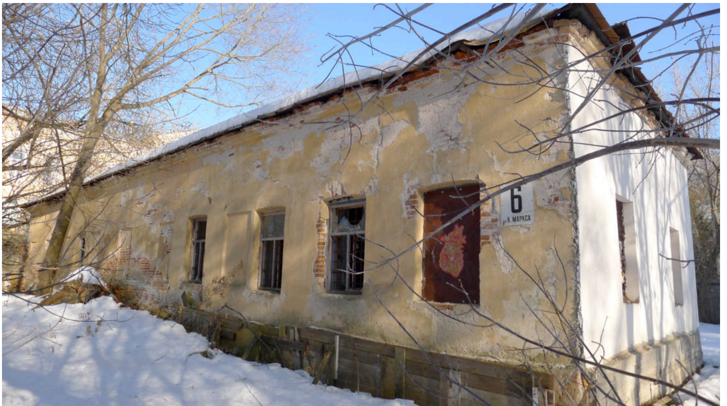
Фото 8. Западное крыло. Вид с юго-запада.
